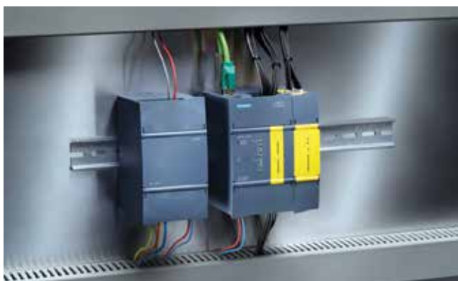
S7-1200 G2 F-CPU a napájací zdroj s diagnostikou
